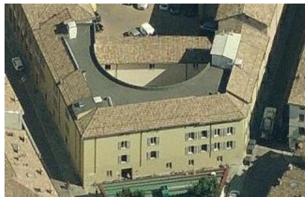
Foto 2- edificio dall'alto- esterno
